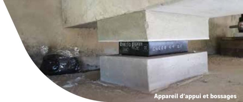
Appareil d'appui et bossages
